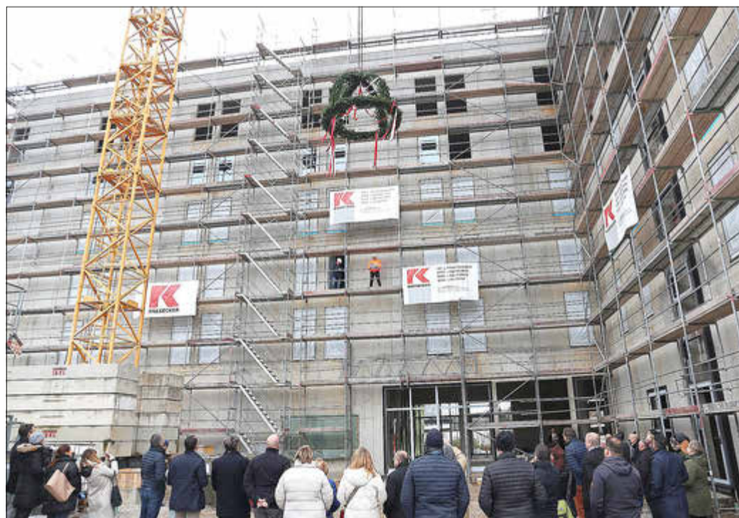
Die Gäste des Richtfests lauschten gespannt dem traditionellen Richtspruch.
