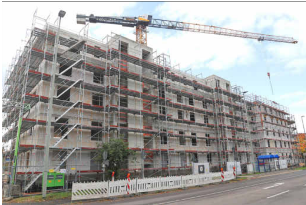
Der Bau der drei Wohnhäuser geht in großen Schritten voran.
