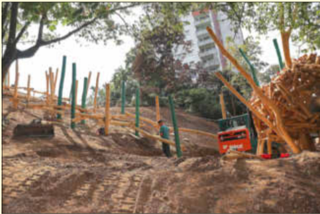
Auch am Kletterparcours wird noch fleißig gearbeitet.
