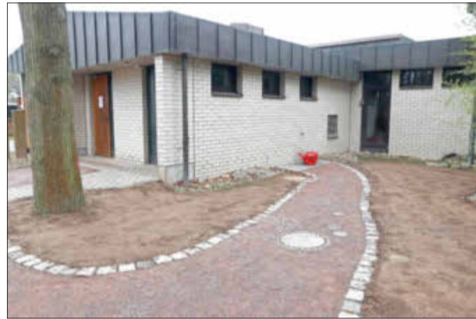
Ein kleiner Weg führt zur neuen Winterzapfstelle an der Außenwand der Toilettenanlage. Foto: (wö)
