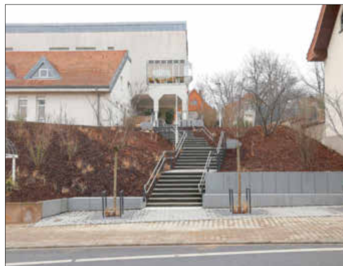
Die neue Treppe zum Fritz-Treutel-Haus kann ab sofort benutzt werden. Foto: (wö)
