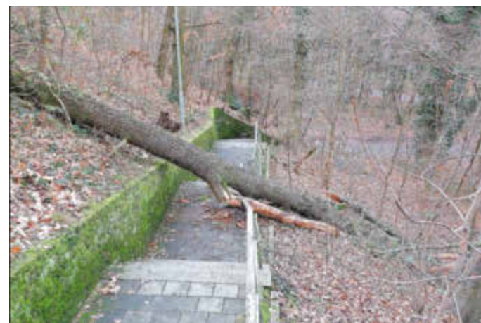
Der umgestürzte Baum blockiert den Weg und hat Geländer und Stufen der Treppe teils stark beschädigt. Foto: (kkb)
