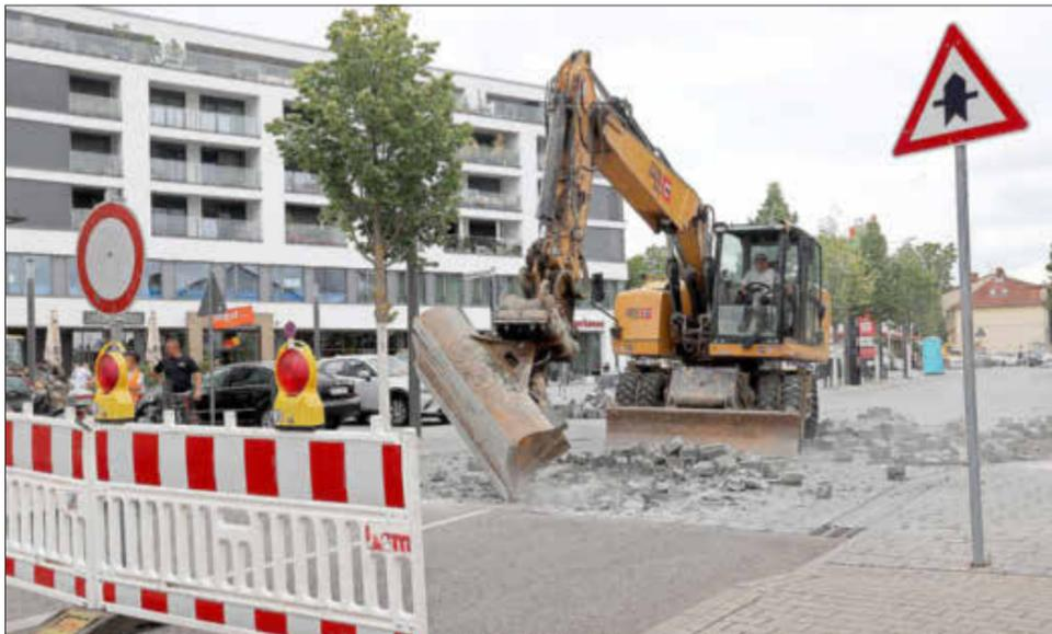
Vergangenen Montag wurde das alte Pflaster aufgebrochen und entfernt.
