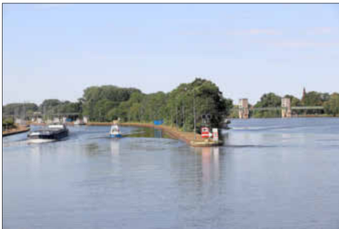
Einfahrt in die Eddersheimer Schleuse.
