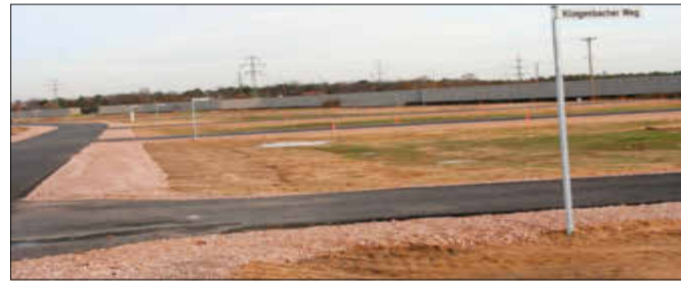
Bald wird sie viel höher sein – die beliebte Gabionenwand.
