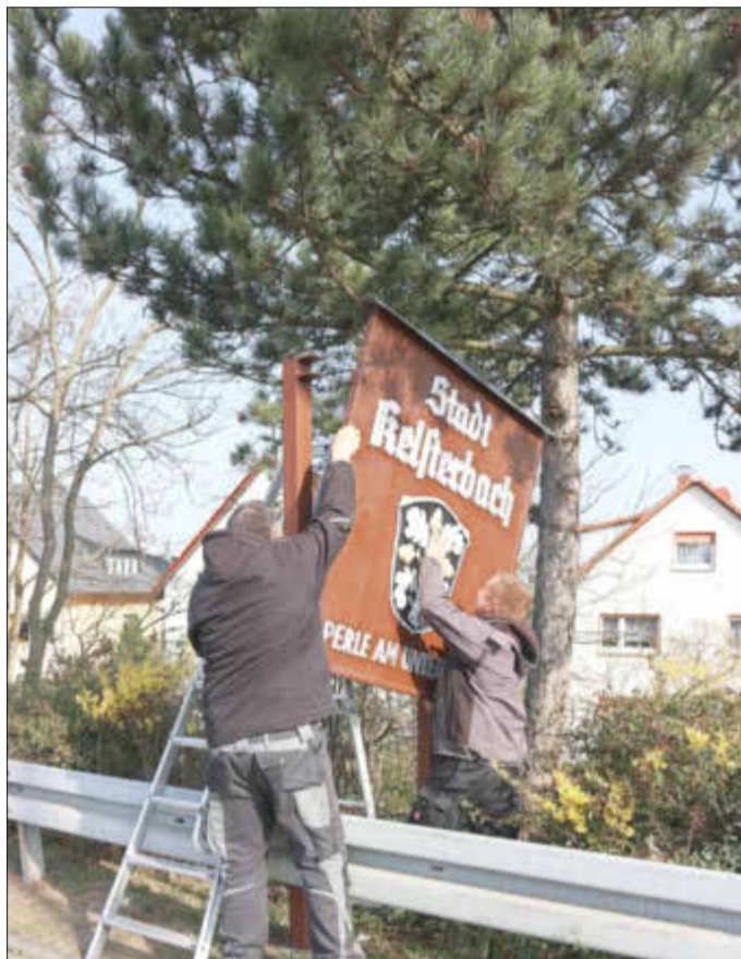
Das Anbringen des massiven Holzschildes ist Schwerstarbeit, denn es muss in der Führung der Stahlleisten eingeschoben werden.
