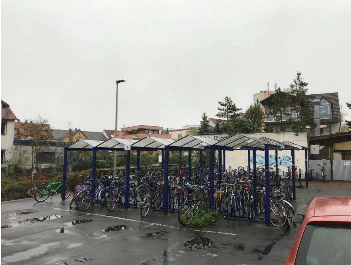
vorhandene Bike+Ride - Anlage auf der Südseite der Verkehrsstation Kelsterbach
