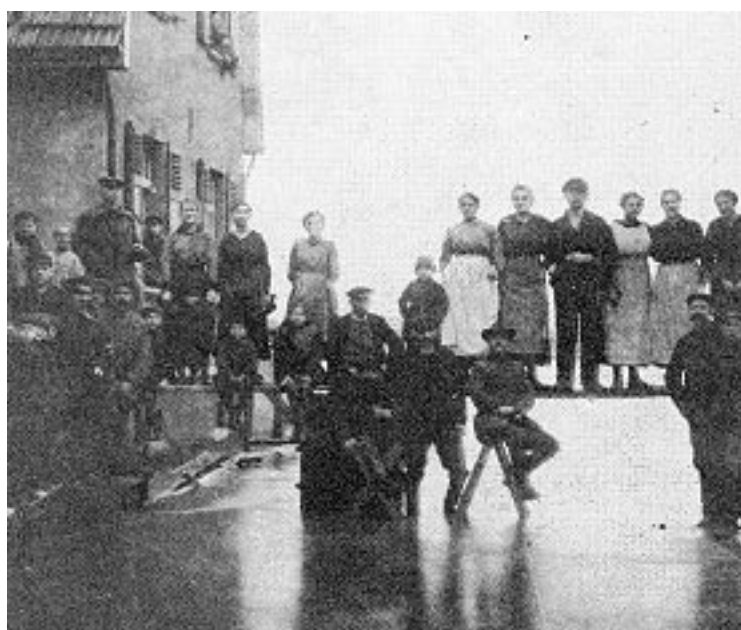
Ein Bild aus alten Kelsterbacher Tagen. Hochwasser im Unterdorf, und die Frauen in der Kittelschürze stellten sich selbstbewusst dem Fotografen.
